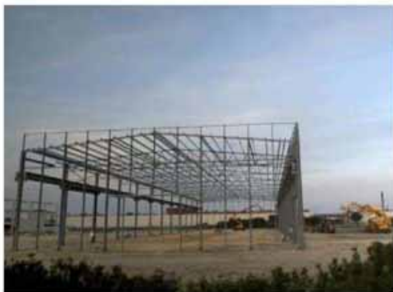
Estructura de una de las naves de Alestis
