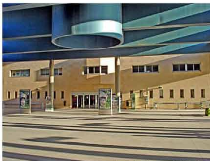
Instalaciones del DTS en Jerez de la Frontera
